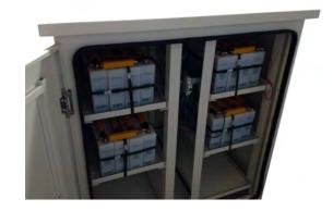
Debido a la necesidad de alimentación eléctrica para equipos de detección de intrusos en las inmediaciones de ductos, se diseñó un gabinete para intemperie NEMA 4X que aloja bancos de baterías para un respaldo de hasta 6 meses.
