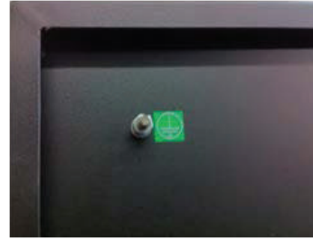
Perno Soldable: 2 piezas, cable de Tierra física: 2 piezas
